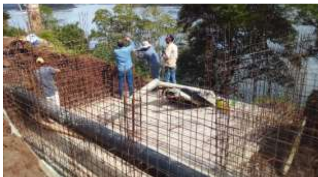
Instalación de caños camisa de acero para nueva Toma de Agua en Río Paraná.
