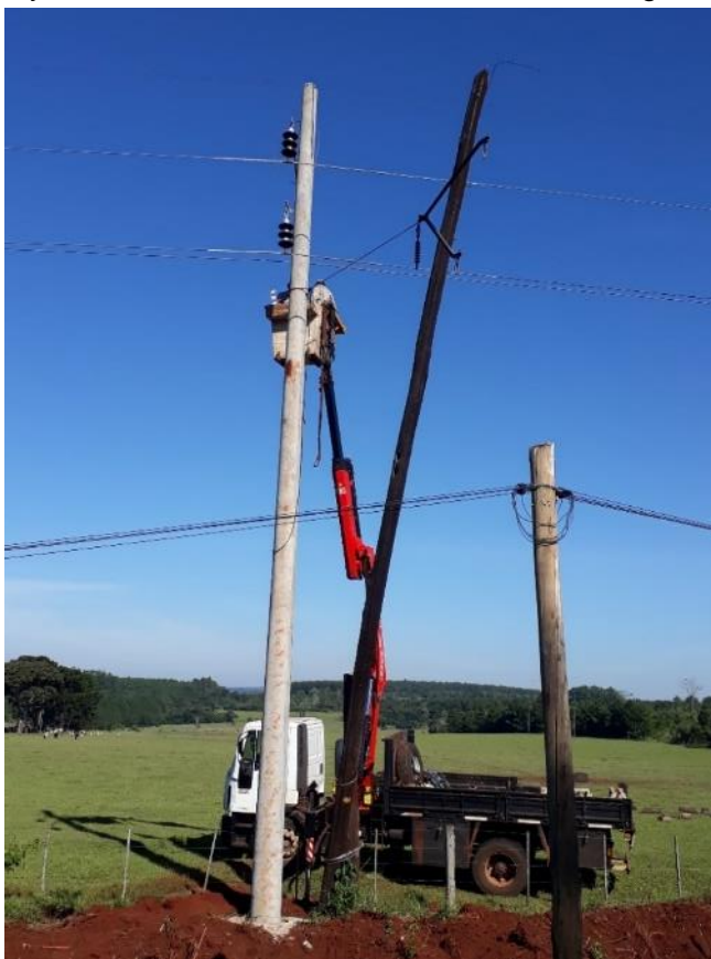
Reemplazo de poste en Ruta N° 12 (Montecarlo – Caraguatay)
