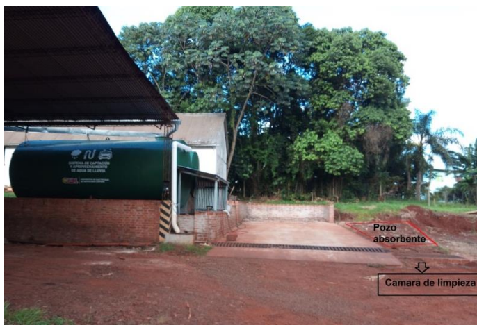
Imagen de Tanques, Pozo Absorbente e instalaciones para lavado de vehículos.
