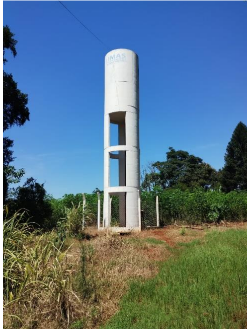
Imagen de tanque elevado Nuevo Guaraypo
