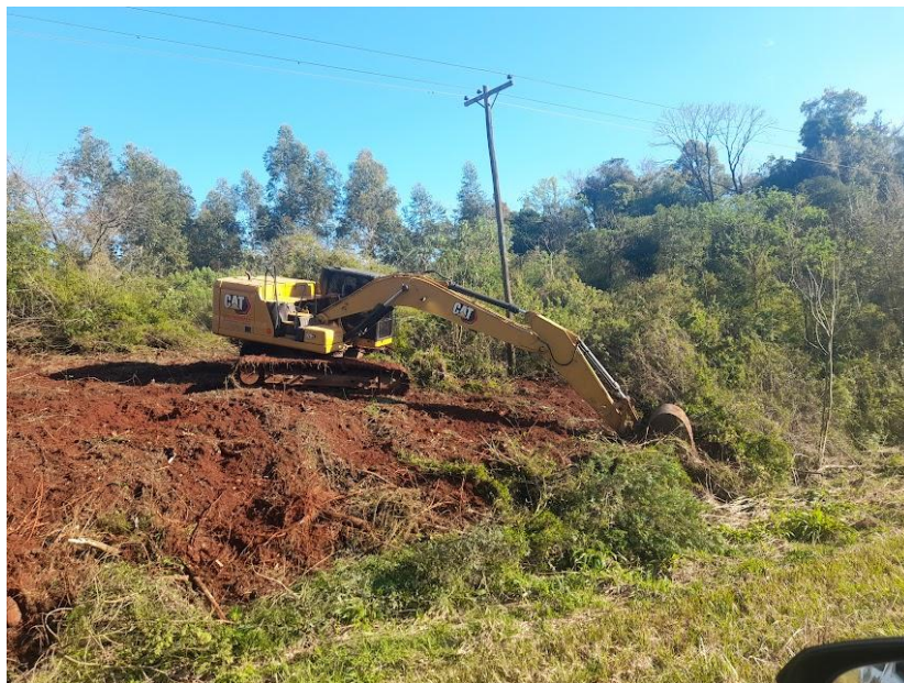
Imagen de trabajos de limpieza línea de 13,2 KV en Colonia Luján
