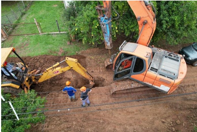
Trabajos realizados en la calle Rómulo Suarez del Barrio Retiro de Montecarlo.
